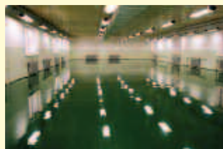
Posadzka przemysłowa z Powłoką Nawierzchniową EP 3
