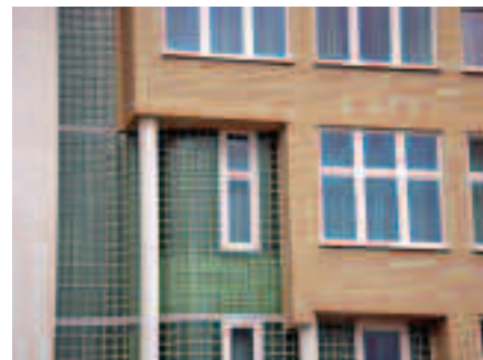
Elewacje fragmentu budynku uczelni wyższej w Kielcach
