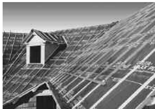
Fot. 3. Ułożona folia wstępnego krycia DELTA® – MAXX PLUS na dachu
