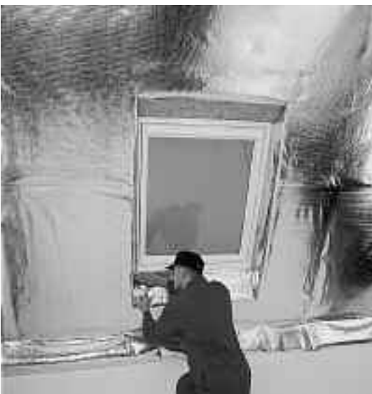
Fot. 1. Montaż folii paroizolacyjnej DELTA® – REFLEX
